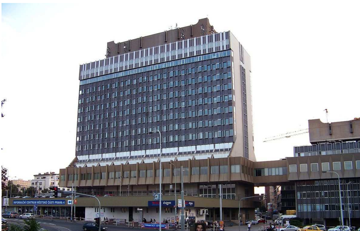
Foto č. 1 - Pohled na komplex budov CENTROTEXu (zdroj: www.wikipedia.org).
